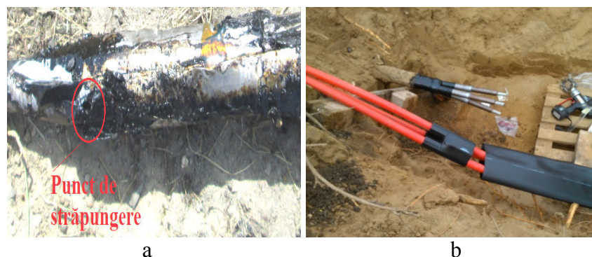
Fig.25 . a) Identificarea punctului de străpungere în mantaua de fontă; b) Manșonarea cablului utilizând două manșoane de tranziție de la cablu HIU la trei cabluri cabluri monopolare cu izolație XLPE.
