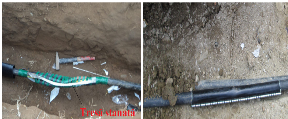
Fig.18. Montarea tresei stanate cu inele de fixare pentru transferul armăturii; Montarea manșonului de tip fermoar termocontractibil
