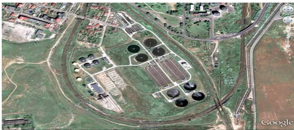
Fig. 2.4 Vedere de ansamblu a amplasamentului SEAU Constanța Sud [ internet ]
