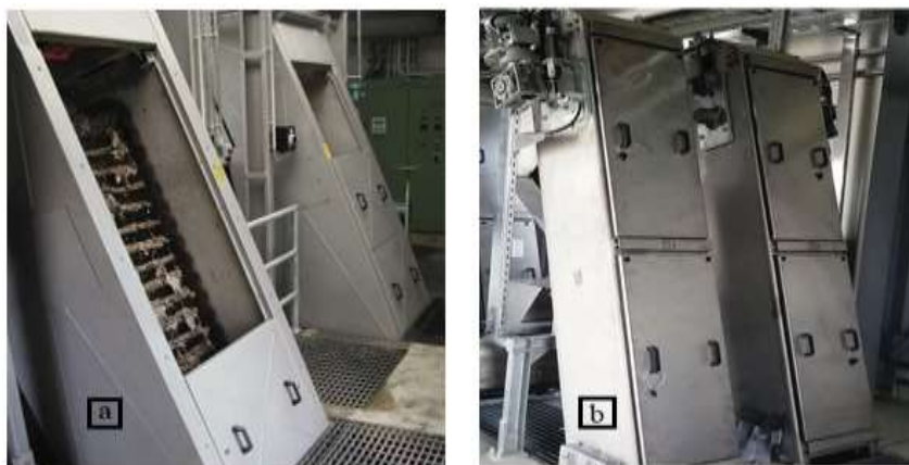
Fig. 6.65. Grătarele dese (a), respectiv rare (b) din structura stației de epurarea apelor uzate orășenești
