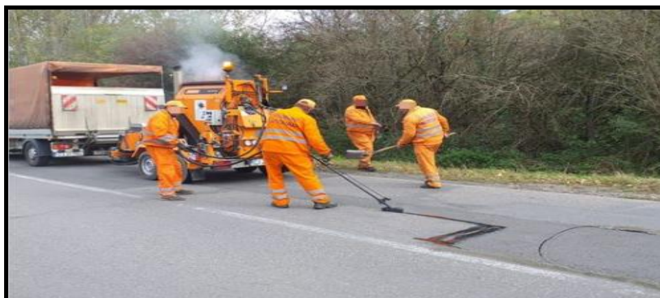
Fig. 5.12. Colmatare fisuri
