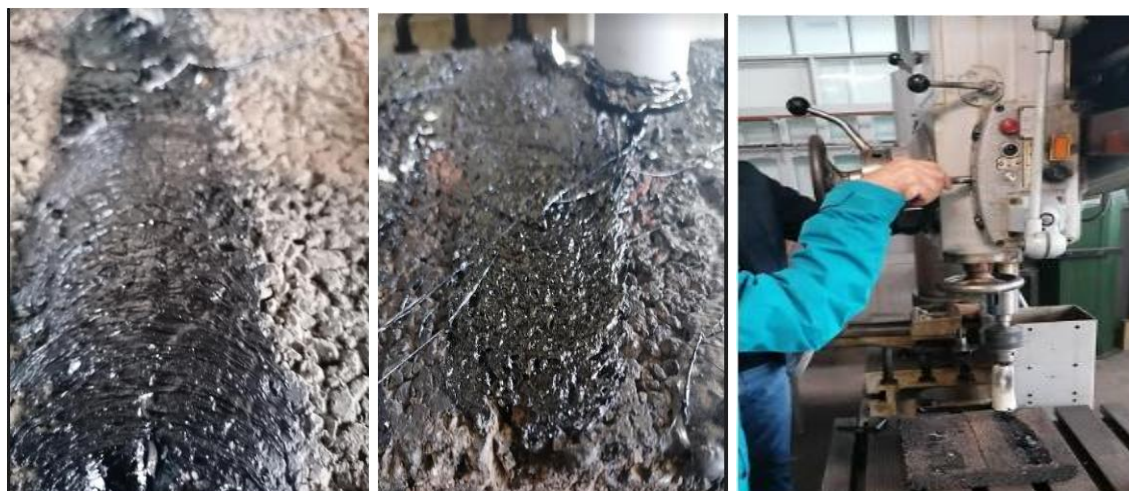
Fig. 5.31. Sigilare fisură în calea de rulare
