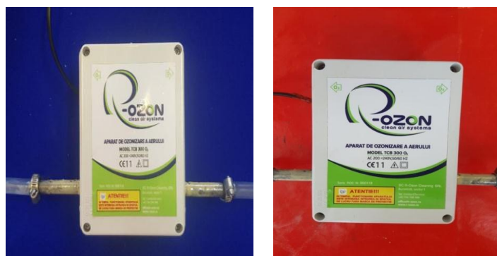
Fig. 6.4. Vedere în plan a generatorului de ozon racordat la conducte [15]
