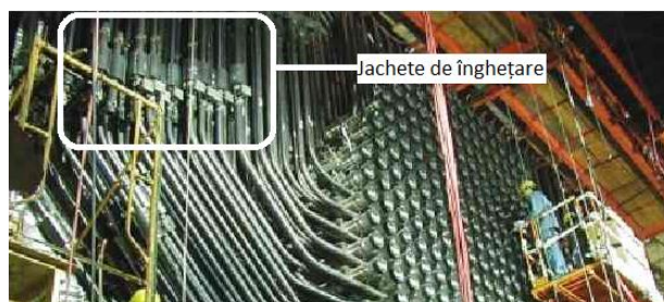
Fig. 2.2 - Jachete de înghețare poziționate pe conducte fider
