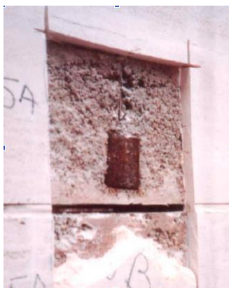
Figura 2. 1. Coroziunea plăcii de ancorare din oțel încorporată în peretele prefabricat din beton [71]
