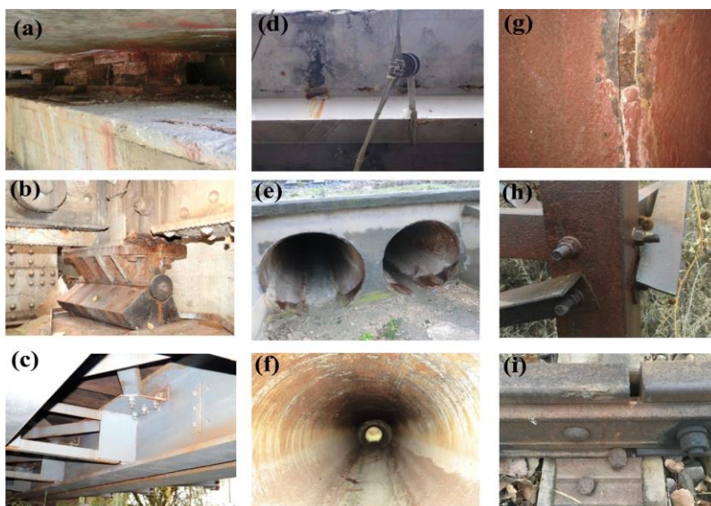
Figura 2. 2. Exemple tipice de defecte de coroziune la diferite părți ale structurilor feroviare din fontă și oțel expuse la atmosferă: (a-d) suport, grinzi și elemente de poduri; (e-g) componente ale canalelor; (h) catenară și (i) elemente de cale ferata [116]
