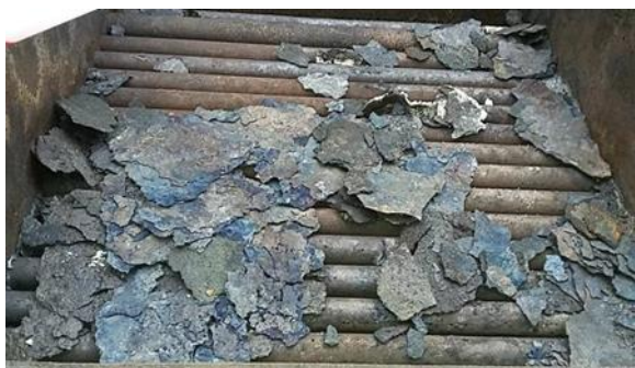
Figura 5. 3 Depuneri de substanțe aderente pe fasciculul de țevi al schimbătorului 120 S1H – aspect general
