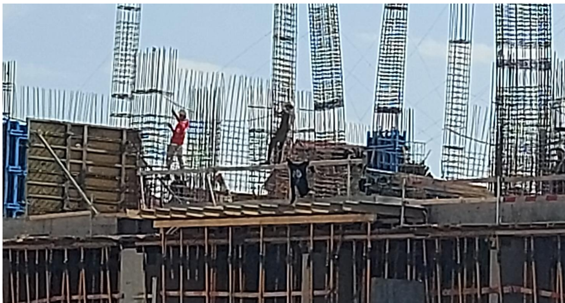
Fig.1.9. Lipsa de coordonare, lucrări suprapuse, lucrători fără EIP minim
