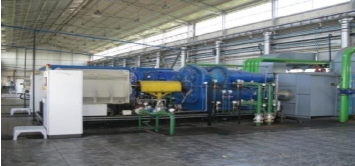
Figura 8 - Compresor centrifugal de aer acționat cu motor electric (CCA) [47]
