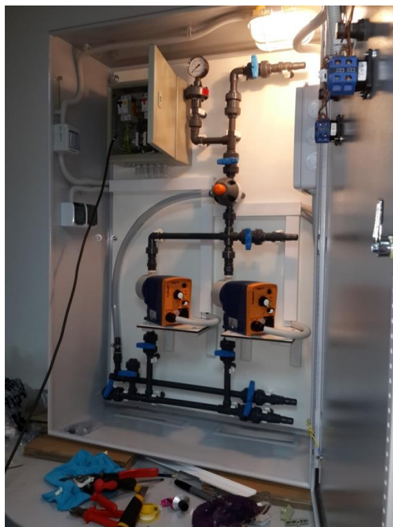
Fig. 3.3. Instalație dozare sodă
