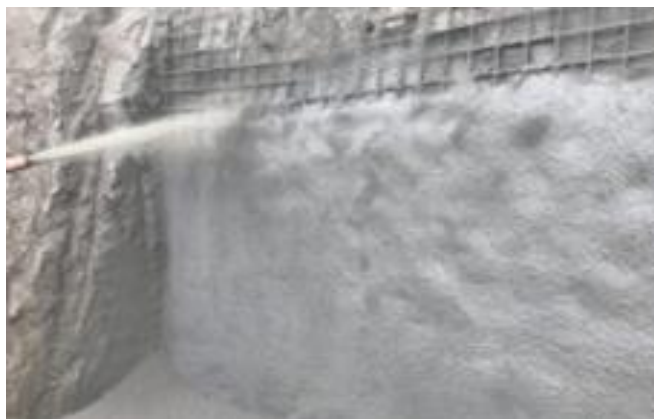
Fig. 5.4. Procedul de torcretare folosit la consolidarea unei structuri de sprijin
