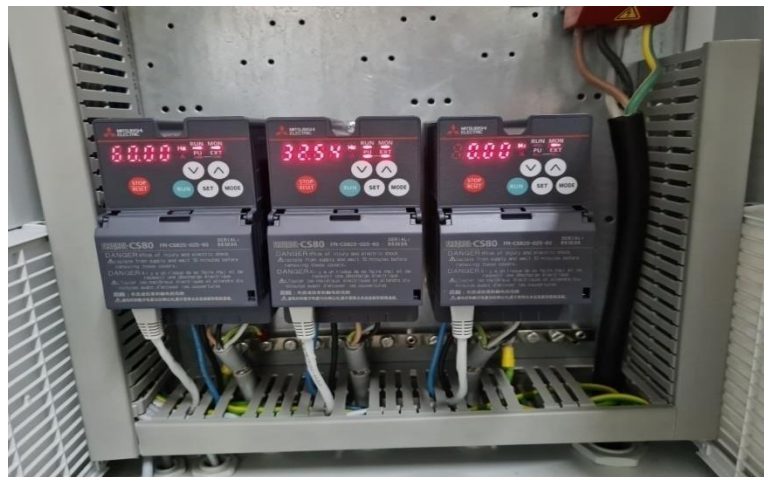
Fig.2.21. Convertizoare de frecvență Mitsubishi FR-CS82S-025-60
