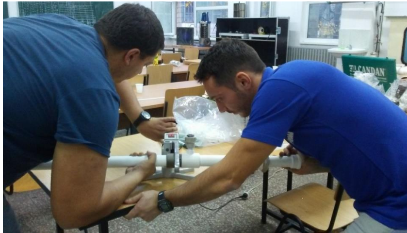
Fig. 2.11. Executarea instalației hidraulice – lipirea tronsoanelor de conductă din PPR
