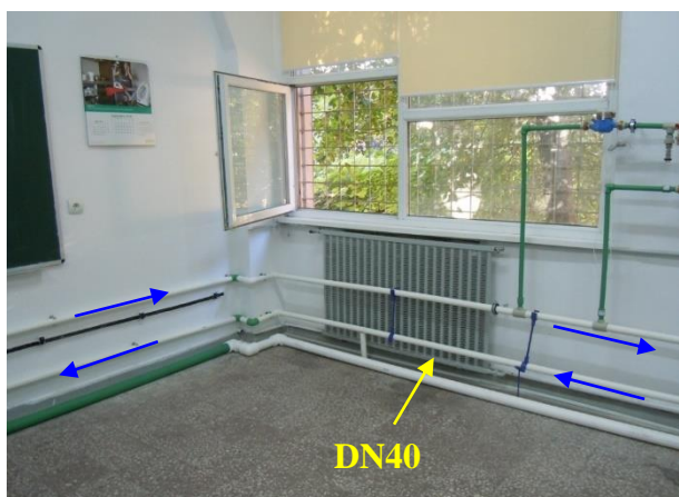
Fig.2.15. Magistrala de aspirație DN40
