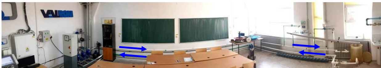
Fig. 2.14. Vedere panoramică asupra standului experimental din Laboratorul de Mașini Hidraulice (ELa 022) – aici magistrala de aspirație are DN63, deci diametru mare (pentru a studia funcționarea pompelor cu sau fără cavitație)
