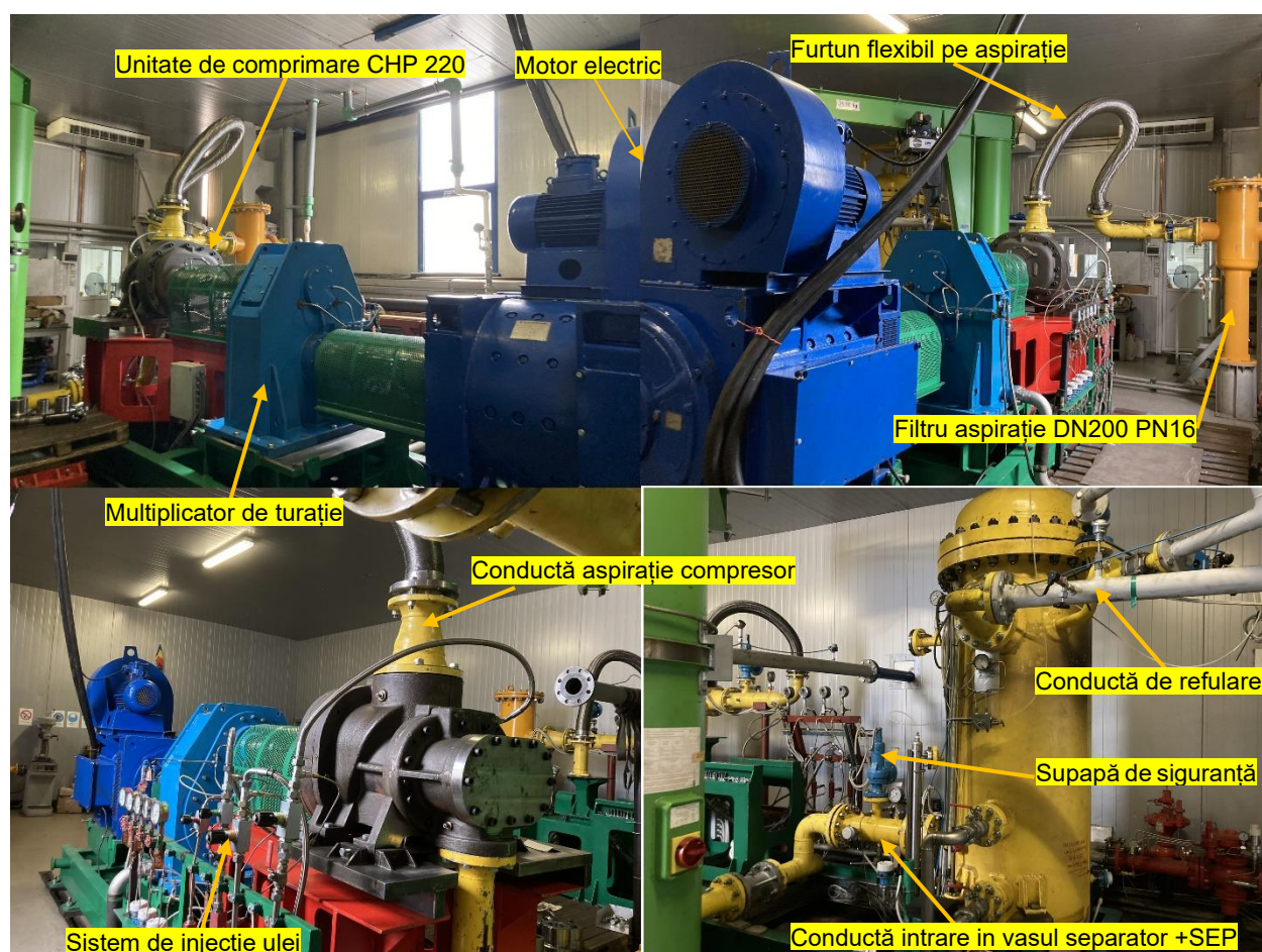
Figura 4.39. Vederi de ansamblu a facilității de testare.
