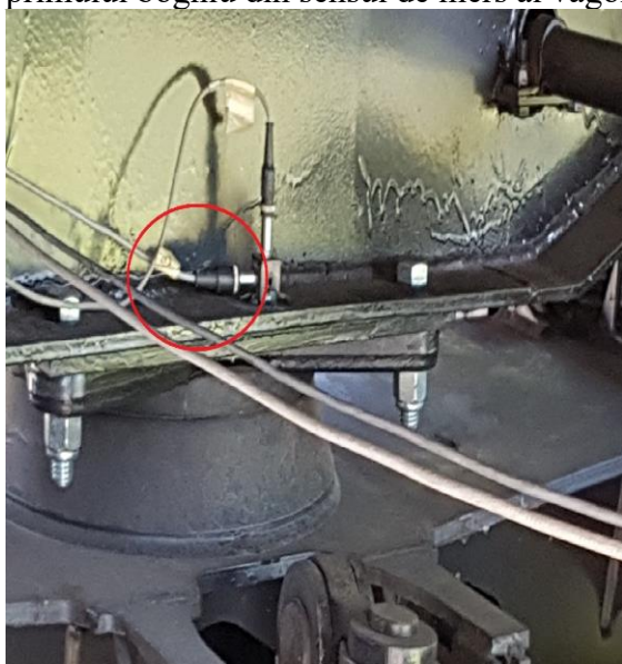
Fig.7.5. Accelerometrul 3 montat pe cutia vagonului, primului boghiu
