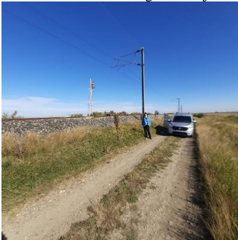
Fig.4. Joanta de pe linia Inelului Mare de la Centrul de Testări Feroviare Făurei
