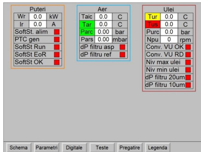
Fig. 15 – Ecran scada parametri funcționali compresor
