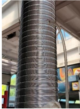
Fig. 19 Execuția punctului de măsurare a calității aerului în tubulatura de la evacuarea aerului filtrat
