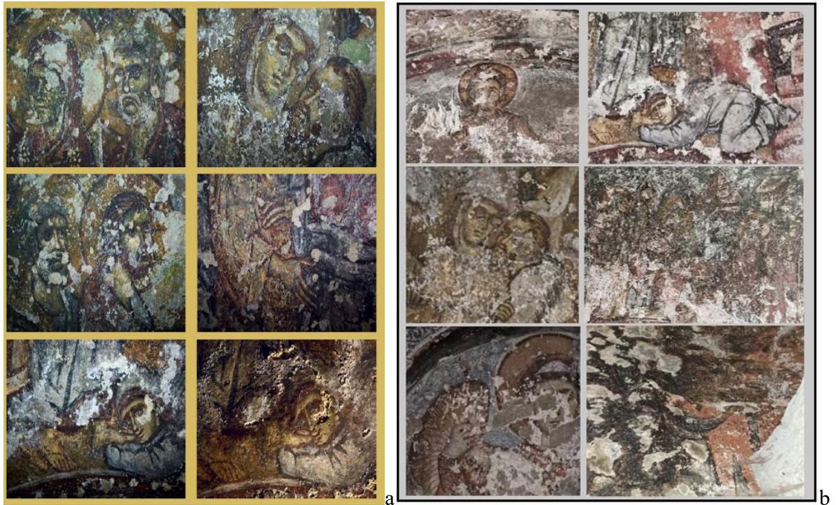
Figura 2.4. Evoluția procesului de degradare a frescei Bisericii Corbii de Piatră în perioada 2011-2022: a-2011; b-2022
