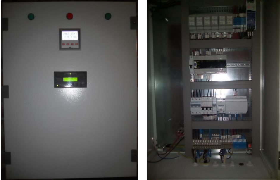
Fig. 18. Tablou comandă și reglaj al tensiunii
