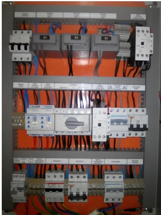
Fig. 15. Tablou alimentare microhidrocentrală
