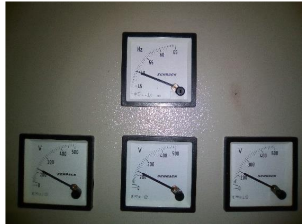
Fig. 15. Tablou alimentare microhidrocentrală
