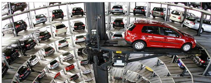
Fig. 3. Deplasarea unui autoturism pe verticală de către elevator în interiorul parcării
