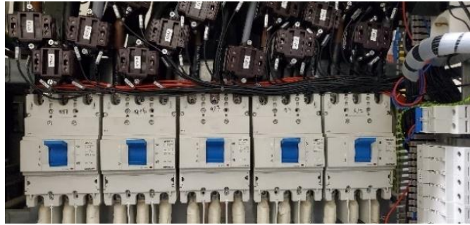
Figura 6.3 Montajul transformatoarelor de curent
